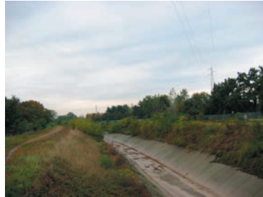
7 The Scolmatore canal
